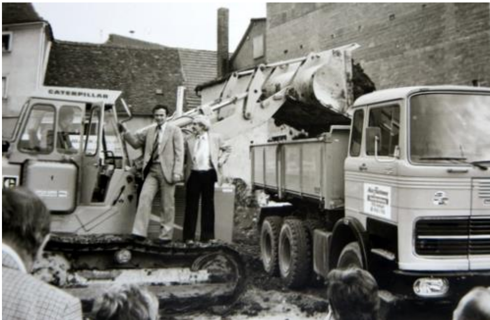
Vorstandsvorsitzender Günther Liepert und Architekt Walter Bauer bei den ersten Bauarbeiten zum Aufbau der Raiffeisenbank Arnstein
