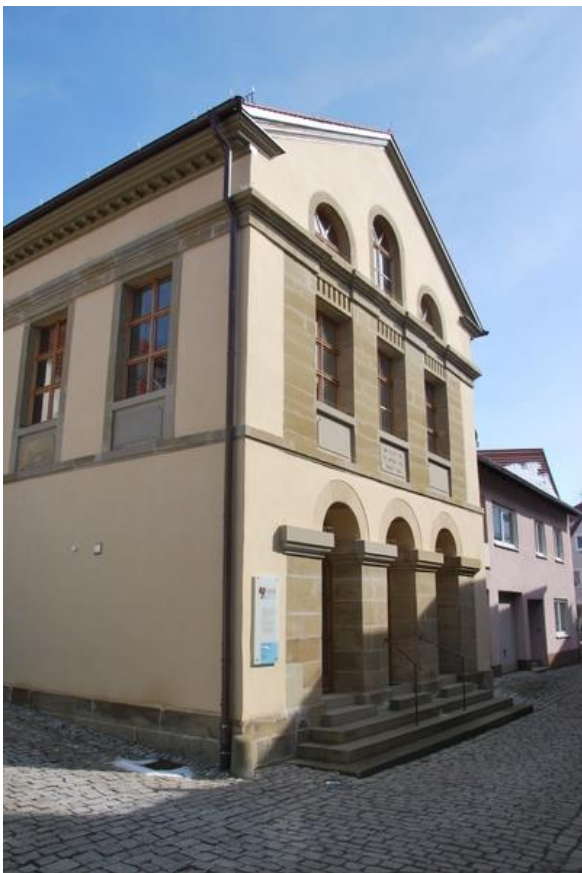
Synagoge nach der letzten Renovierung
