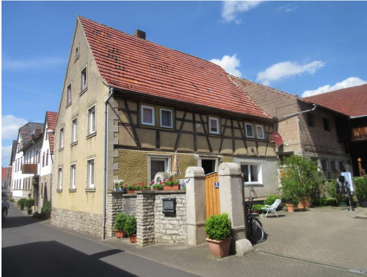
Wohnhaus von Hubert Schöpf, in dem viele Jahre die Rechnergeschäfte abgewickelt wurden
