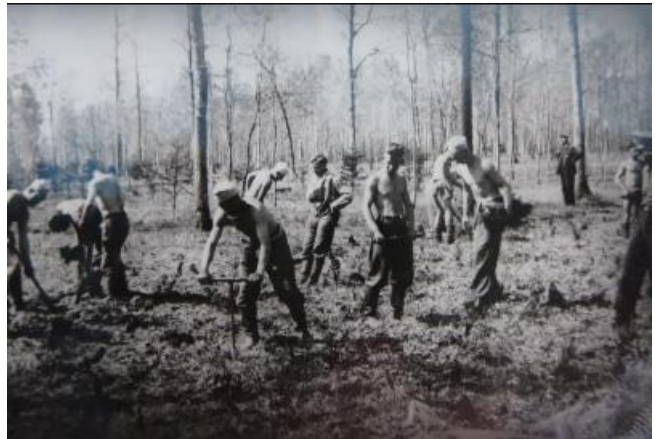
1Arbeiten in der Lau (Foto privat)
