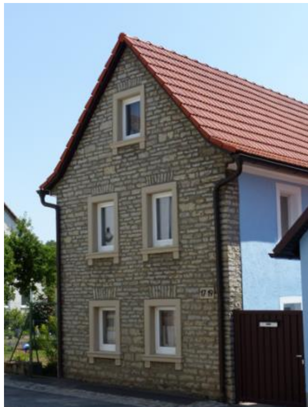
Im Haus der Brühlstr. 17 wurden fünfzig Jahre die Kassengeschäfte der Bank abgewickelt
