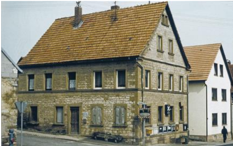
Das letzte Zahlstellengebäude am Steinweg 2
