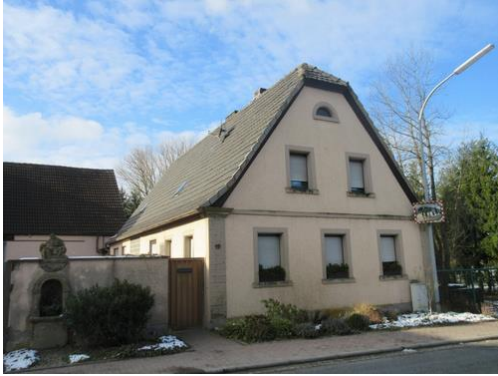
In diesem Gebäude in der Retzstadter Straße führte bis zum Neubau der Rechner seine Geschäfte
