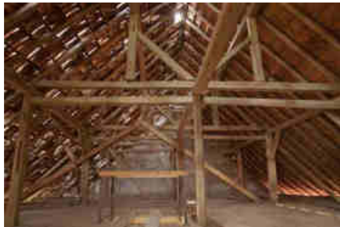
Der Dachstuhl der Scheune (Foto Mattias Kühnl)
