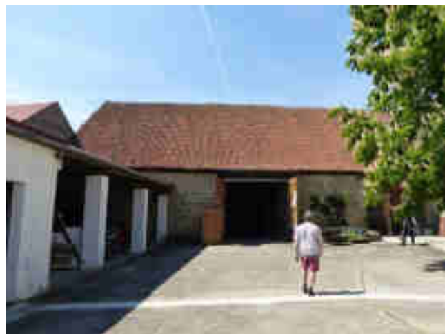
Blick auf die Nebengebäude
