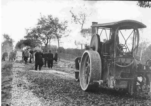
Heute werden fast nur noch Maschinen zum Straßenbau benutzt
