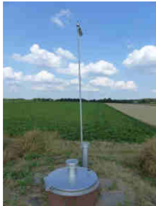
Der neue Wasserbehälter
