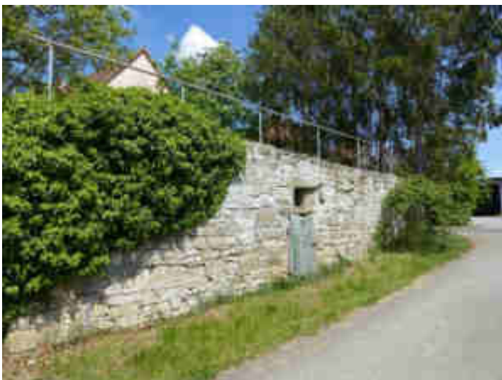
Heute ist von dem ehemaligen Gebäude nur noch dieses Mauerstück zu sehen
