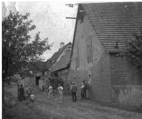
Der neu eingebaute Scheunenaufzug (Sammlung Willi Albert)
