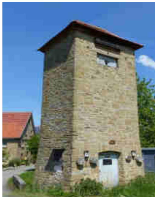
Das ehemalige Transformatorhaus wird nunmehr als Insektenhaus genutzt
