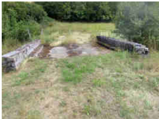
Brücke über den Hörleinsgraben
