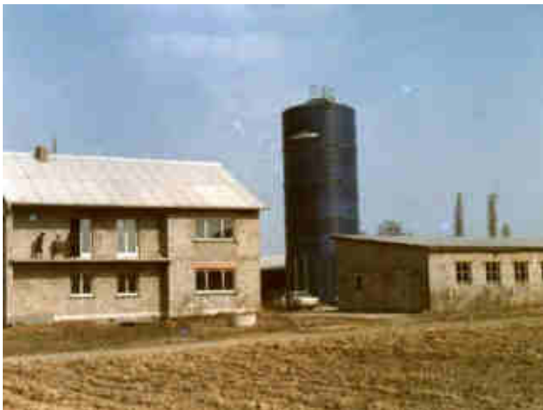
Das Hofgebäude nach Fertigstellung des Rohbaus (Sammlung Emma Kriebel)
