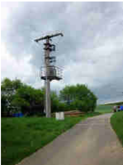
Heute wird der Weiler über eine Fernleitung des ÜZ Lültsfelds versorgt.
