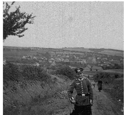
Der RAD beim Wegbau nach Ruppertzaint hat 1933/34 den Ruppertzainten Berg in Handarbeit oben abgegraben und unten angefüllt.
