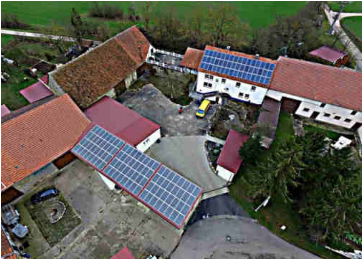
Luftbild von 2017 (Foto Mattias Kühnl)
