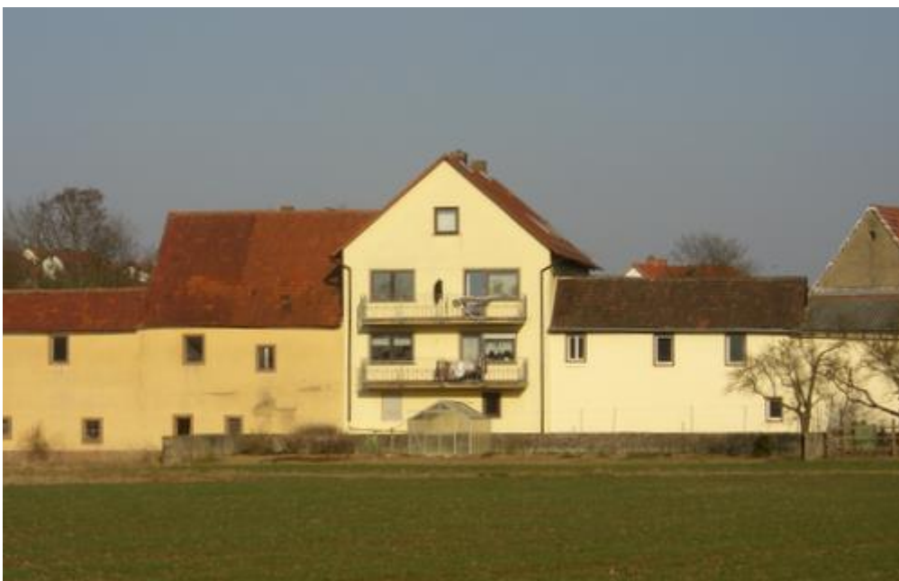
Magistratsrats Schmitt war Eigentümer der Mühle in der Karlstadter Straße 37
