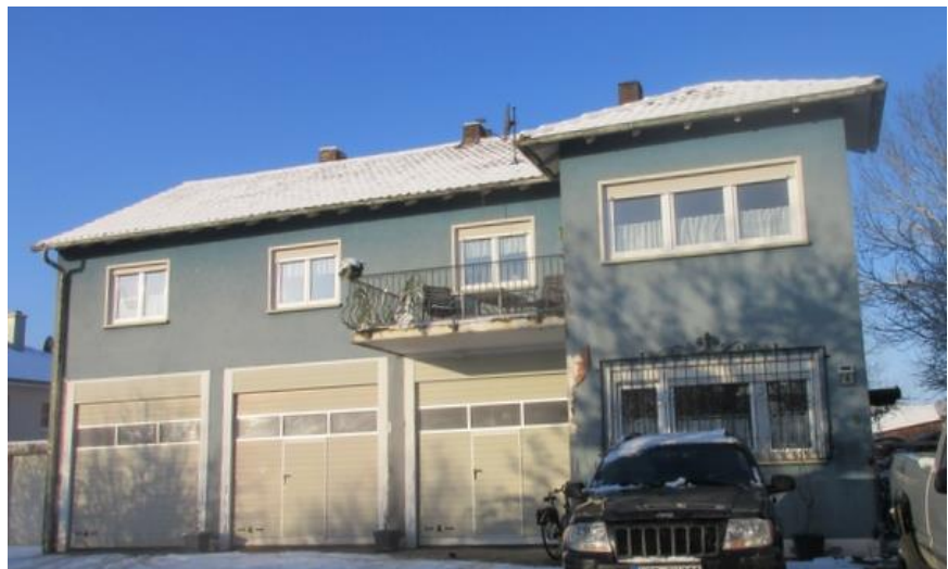
Eine Winteraufnahme des Gebäudes
