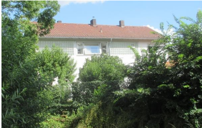
Die Westseite des Gebäudes zur Schwabbach hin. Anfangs war die Loggia noch nicht mit Fenstern und Glasbausteinen versehen.
