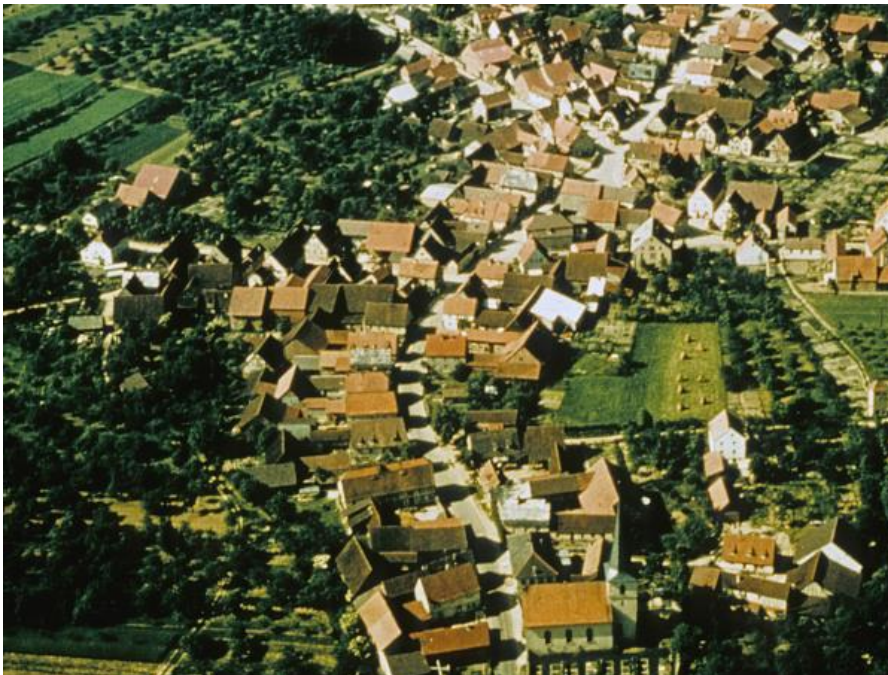
Wülfershausen in den 60er Jahren
