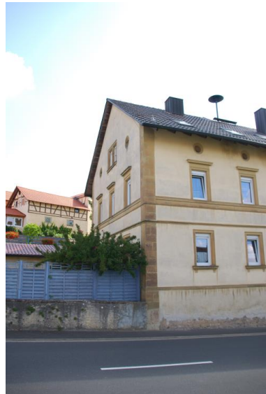
Das Apothekengebäude in der Langendorfer Straße 6
