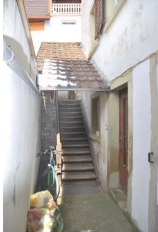
Treppenaufgang von der Goldgasse zur Marktstraße (Foto März 2013)
