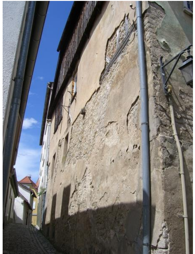
Während das Gebäude unten aus massivem Stein gebaut ist, wurde oben ein Fachwerkbau errichtet
