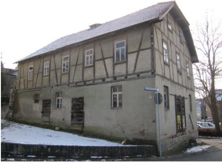
Das Lagerhaus von der Nordseite (Aufnahme vom Februar 2013)
