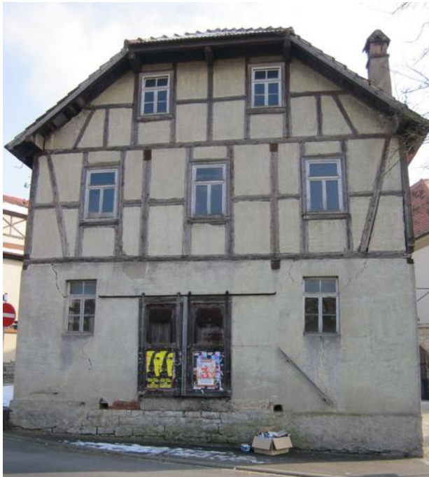
Auf der Westseite des Gebäudes zum Schützenberg durfte keine Rampe angebracht werden
