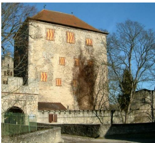
In Thüngen wurde im 19. Jahrhundert eine Schäferschule errichtet
