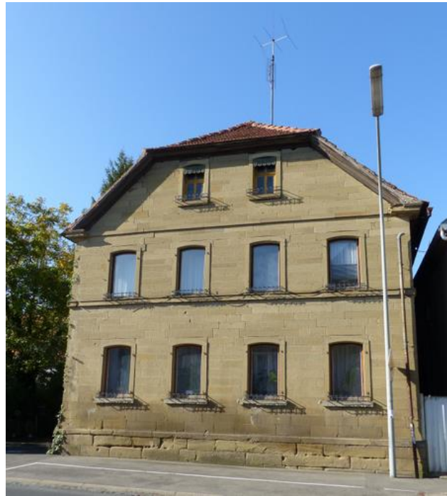
Das gegenwärtige Gebäude wurde Mitte des 19. Jahrhundert aus Sandstein errichtet
