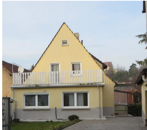
Bahnhofstraße 1; gehörte früher auch zum Sickersdorfer Hof. Unter diesem Haus war ein Keller, der zum Haus Würzburger Straße 4 gehörte
