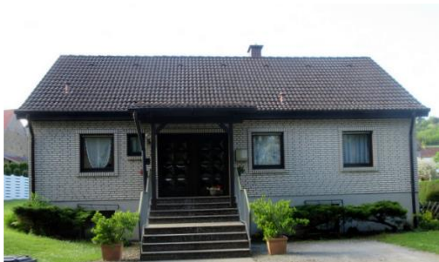
Dieses Haus baute sich Georg Jöst als Alterssitz
