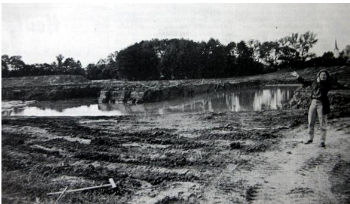
Der See wird ausgebaggert
