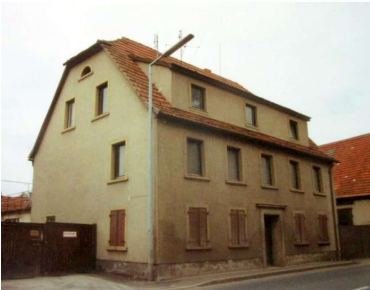
Nach dem Krieg wohnte Jakob Destrée einige Zeit in der Grabenstr. 13, einem Gebäude, das der BayWa gehörte
