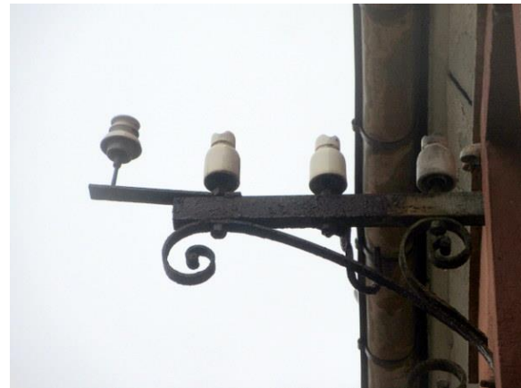
Der Strom wurde noch überirdisch weitergeleitet
