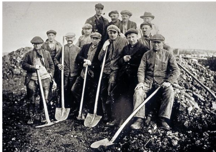
Zu den Hand- und Spanndiensten der Dorfbewohner gehörten neben dem Straßenbau natürlich auch Maßnahmen der Stromversorgung (Foto Stadtarchiv Arnstein)
