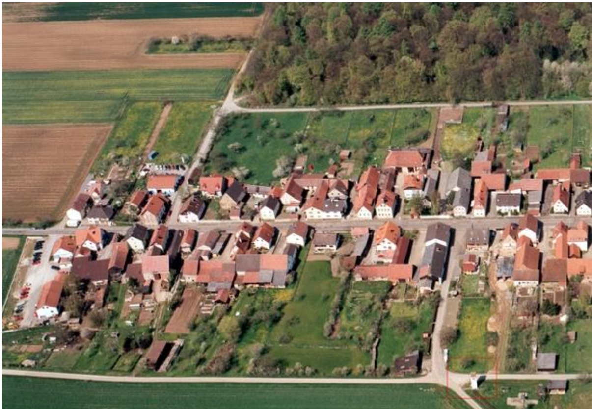
Eine Luftaufnahme aus dem Jahr 2001: Ganz unten rechts ist noch das 1924 neu gebaute Transformatorenhaus zu sehen.
