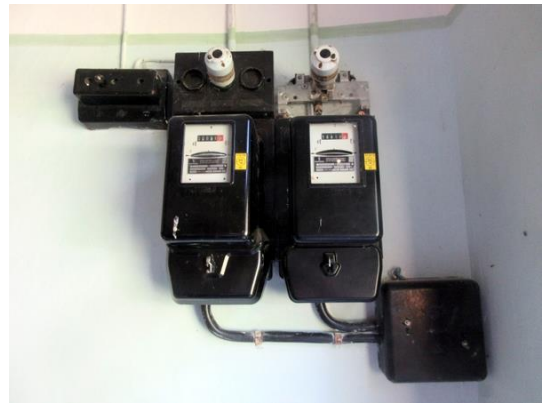
Solche Zähler wie damals eingebaut wurden, gibt es heute nicht mehr
