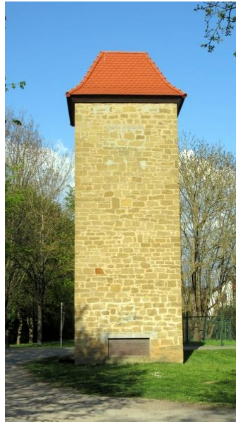
Solch ein Transformatorenhaus wie in Arnstein am Wernweg stand, wurde auch in Neubessingen gebaut
