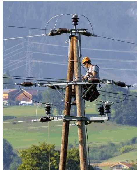
Vor dem Strombezug mussten erst Leitungen gebaut werden
