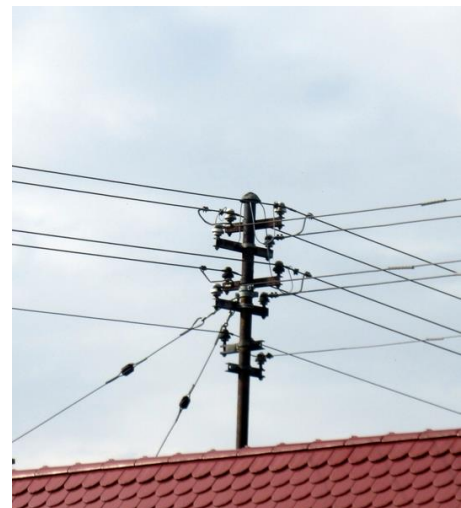
Nach dem Dachständerbau mussten die Dächer wieder instandgesetzt werden
