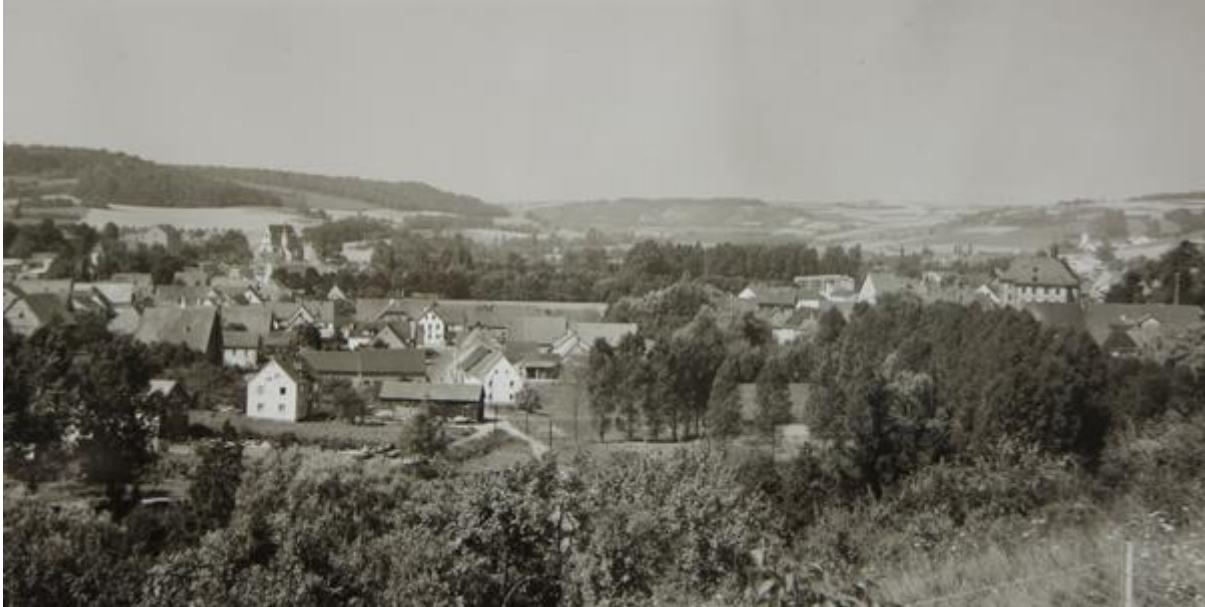
Blick auf die Point
