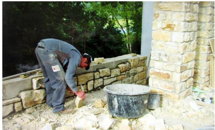
Bruchsteinarbeiten waren eine Spezialität der Firma Fischer
