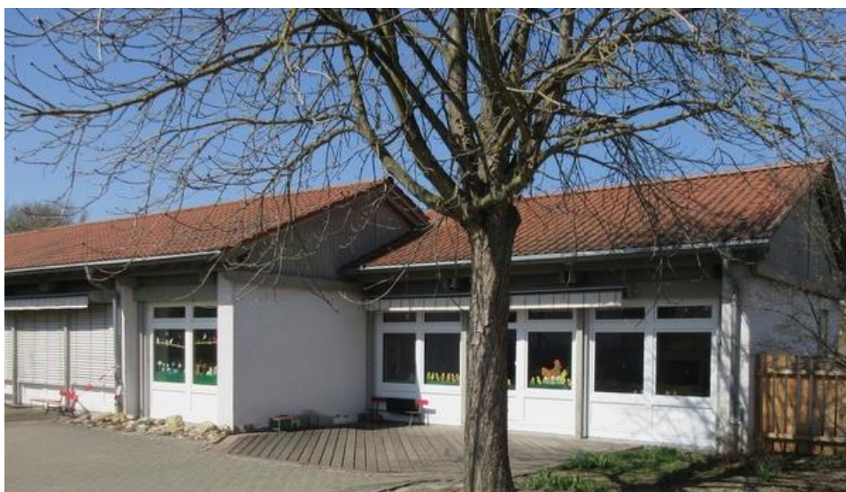
Rückgebäude des Kindergartens
