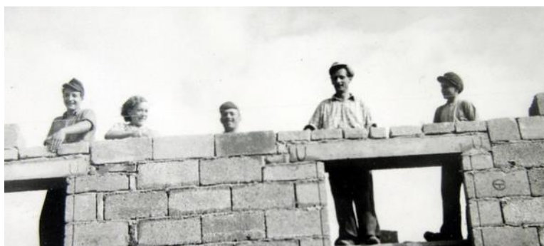
Wahrscheinlich auch eine Baustelle, an der vor allem am Samstag gearbeitet wurde
