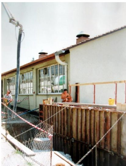
Eine große Baustelle war die Firma AST in der Schweinfurter Straße
