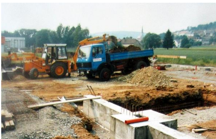
Ein großer Auftrag war die Errichtung des städtischen Bauhofes am Alten Schwimmbad
