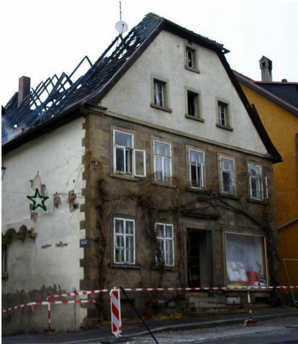
Das Gebäude kurz nach dem Brand
