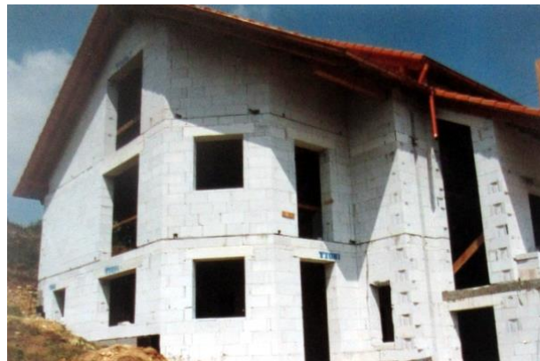
Einfamilienhausbau durch die Firma Martin Fischer
