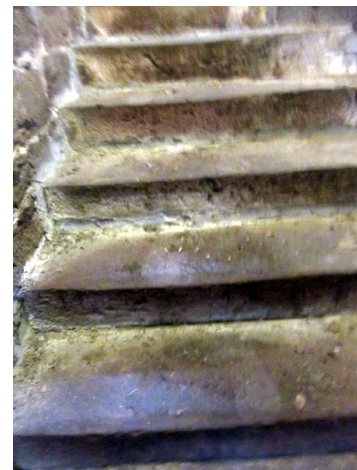
Die Kellertreppe ist ziemlich abgerieben
