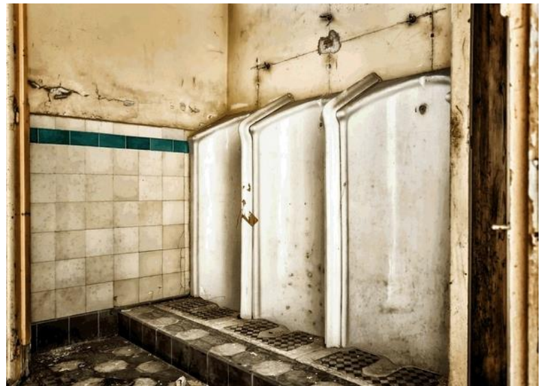
Immer wieder wurde ab etwa 1900 auch eine Pissoiranlage gefordert
