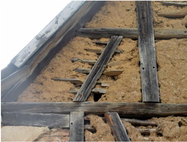
Wenn das Fachwerk nicht gepflegt ist, schaut es bald so aus wie auf diesem Foto
