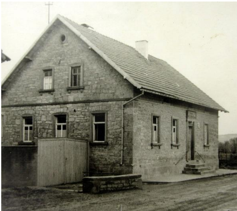
Südwest-Ansicht des Gebäude. Über der Türe kann man noch leicht das Wirtshausschild erkennen
