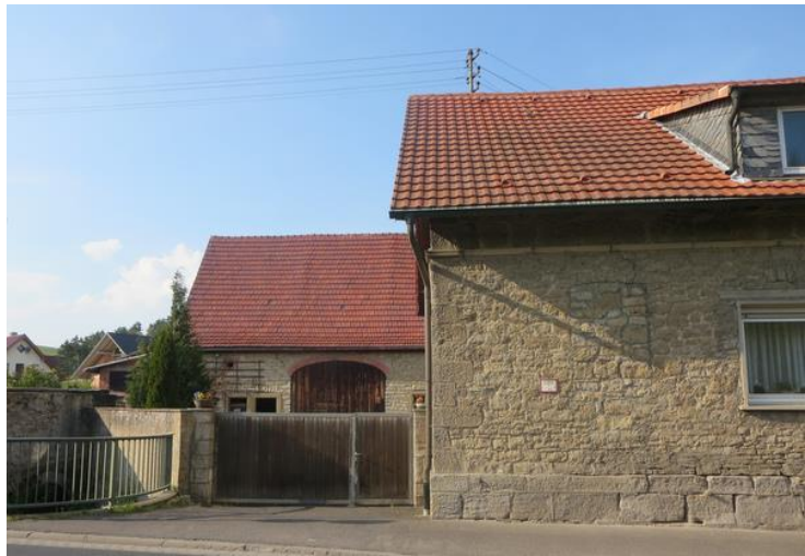
Links in der Scheuer war das Schlachthaus eingebaut. Doch damals gab es noch keine Stromleitungen auf dem Dach.
