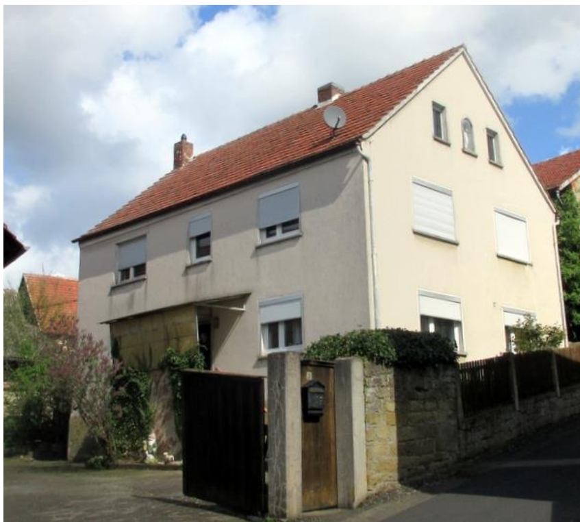
Das Gebäude am Schneidersberg 2 heute
