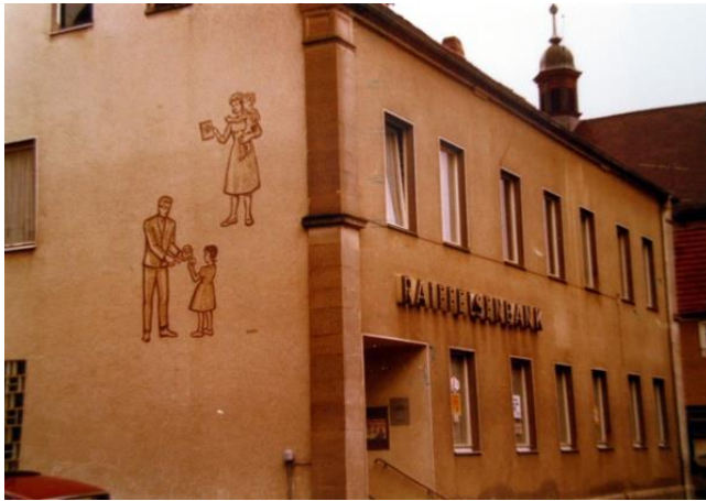
Auch durch Georg Hanfs Einsatz geschah 1962 der Umzug in die Marktstr. 57
