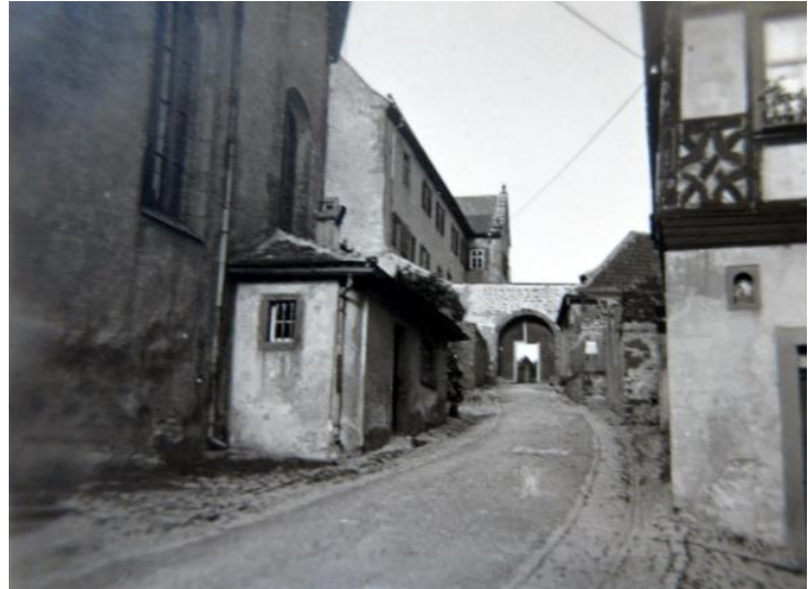
Eingang zum Amtsgericht; vorne die alte Sakristei
