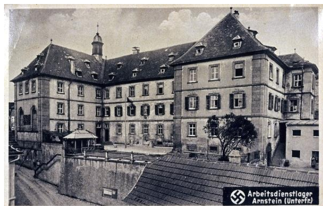
Ansichtskarte aus den Zeiten, als die RAD den wesentlichen Teil des Gebäudes in Anspruch nahm
