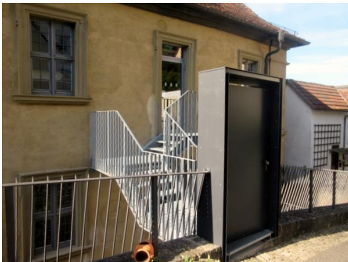
Heute gibt es statt Nebentreppen Feuertreppen, die vom Brandschutz gefordert werden
