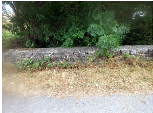
Die Brücke über die Schwabbach bei der Zinkenmühle
