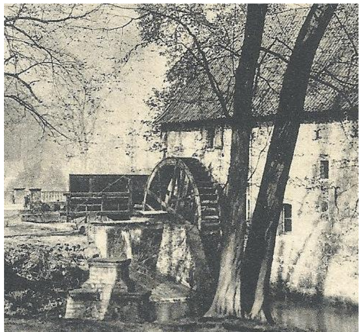
Ein Mühlrad, das durch eine Wasserrinne angetrieben wird.
