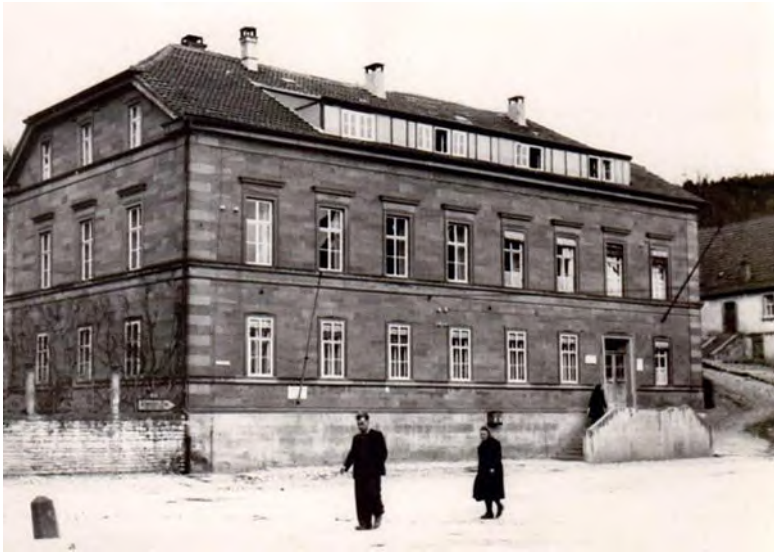
Das Adami-Haus in der Marktstr. 65, das zwischenzeitlich abgerissen ist, wäre das ideale Haus für das Internat gewesen (Foto Stadtarchiv)
