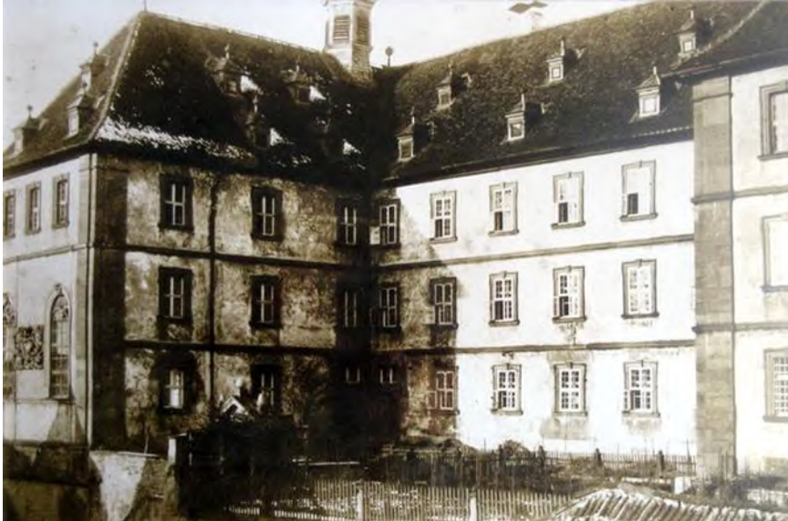
Im Pfründnerspital wurden in der Wohnung des Verwalters vier Zöglinge untergebracht (Foto Stadtarchiv Arnstein)
