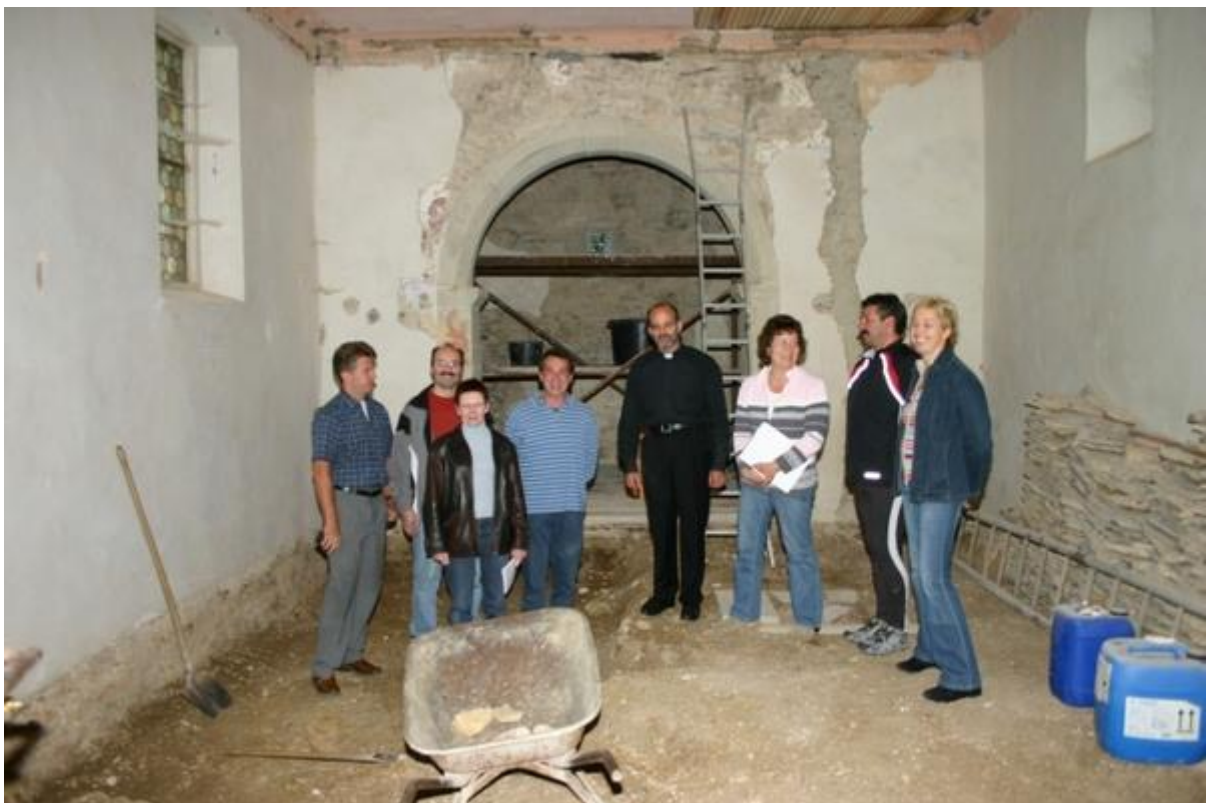
Während der Renovierung; die Personen entsprechen dem Foto weiter oben (Foto Elisabeth Eichinger-Fuchs 2005)
