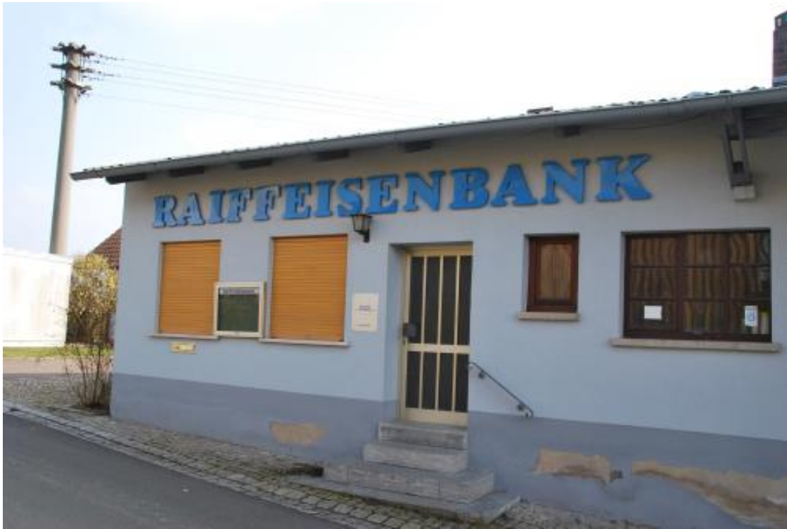
Hier das Raiffeisengebäude zu einem Zeitpunkt, als es bereits nicht mehr als Bankgebäude genutzt wurde.
