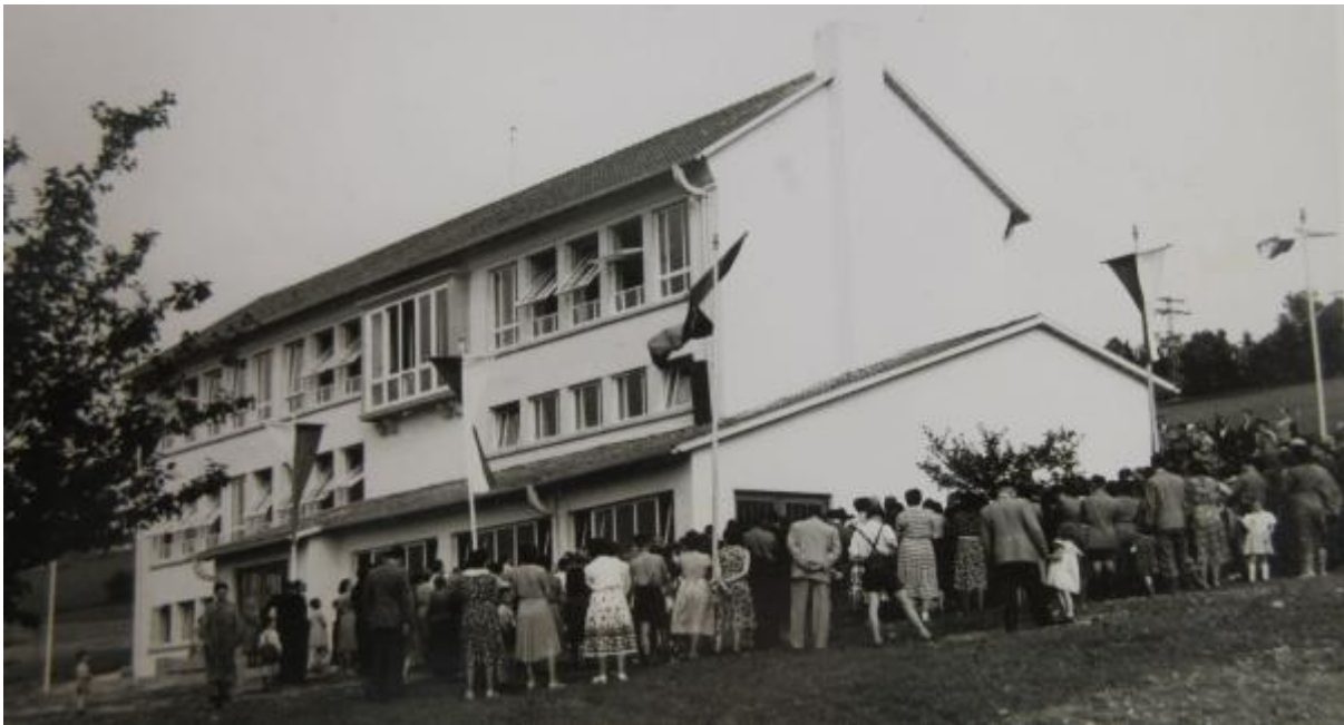
Die Einweihung des neuen Schulhauses in der Schwebenrieder Straße (StA Arnstein Nachlass Lembach)
