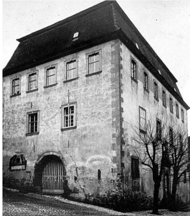
Im Rathaus Arnstein wurden 1926 zwei neue Schulsäle errichtet (Foto Karl Michael Fischer)
