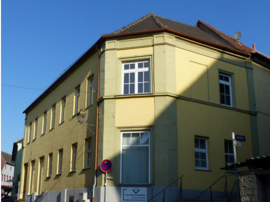
Das Gebäude nach dem Umbau zur Raiffeisenbank
