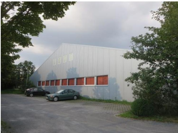
*Weil die Westwand von der Sonneneinstrahlung schwarz geworden war, wurde eine neue wärmedämmende Verkleidung angebracht.*
